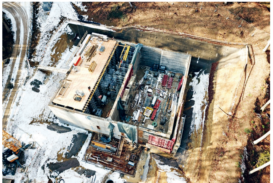
Reservoir Bärenwiesli im Rohbau
